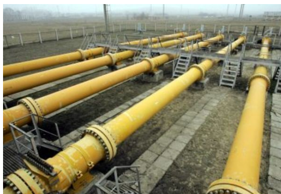
Slika 14: Nizkotlačni plinovod
