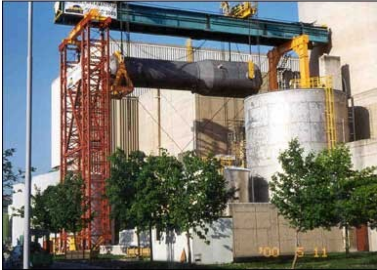
Slika 28: Zamenjava uparjalnika
