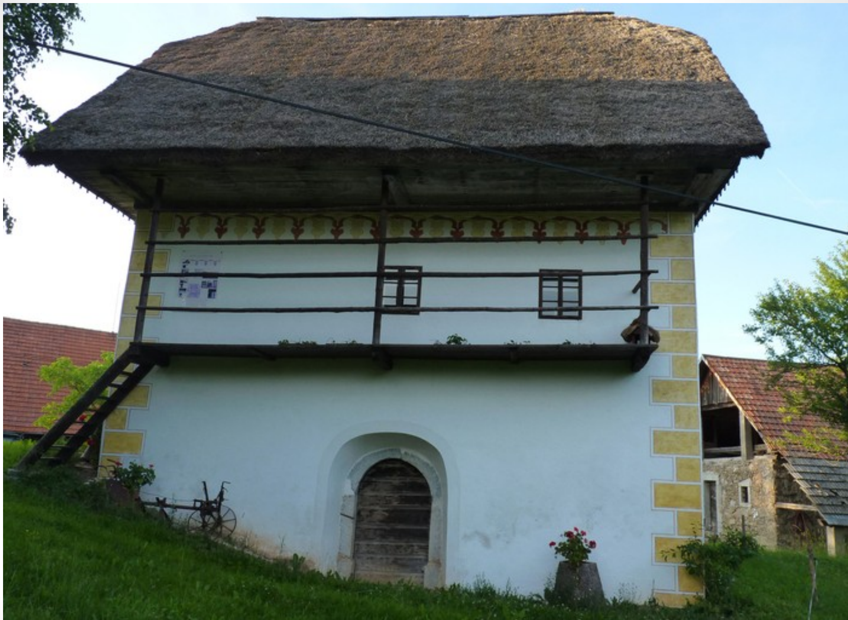
Južna fasada kašče z gankom za sušenje pridelkov in s polkrožno sklenjenim kletnim portalom.
