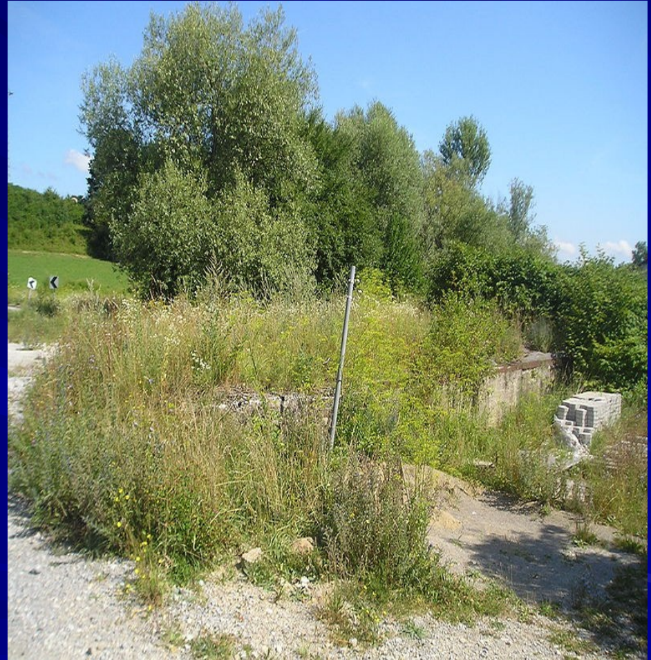
Ostanki rampe na nekdanji vrhniški postaji
