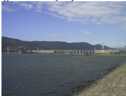
Slika 6: Jez in hidroelektrarna Železna vrata
