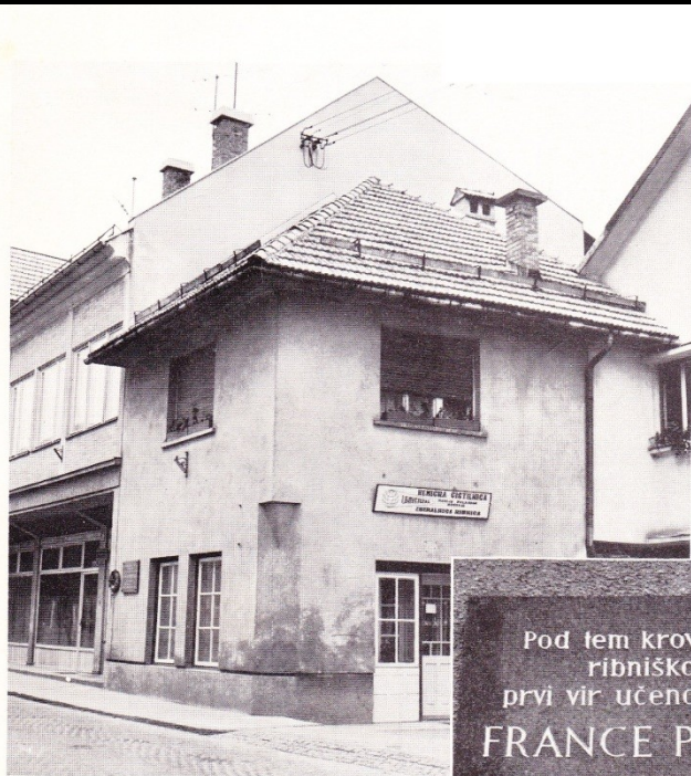
Obnovljena stavba nekdanje osnovne šole (normalke) v Ribnici, ki jo je Prešeren obiskoval v šol. l. 1810/1811 in 1811/1812.
