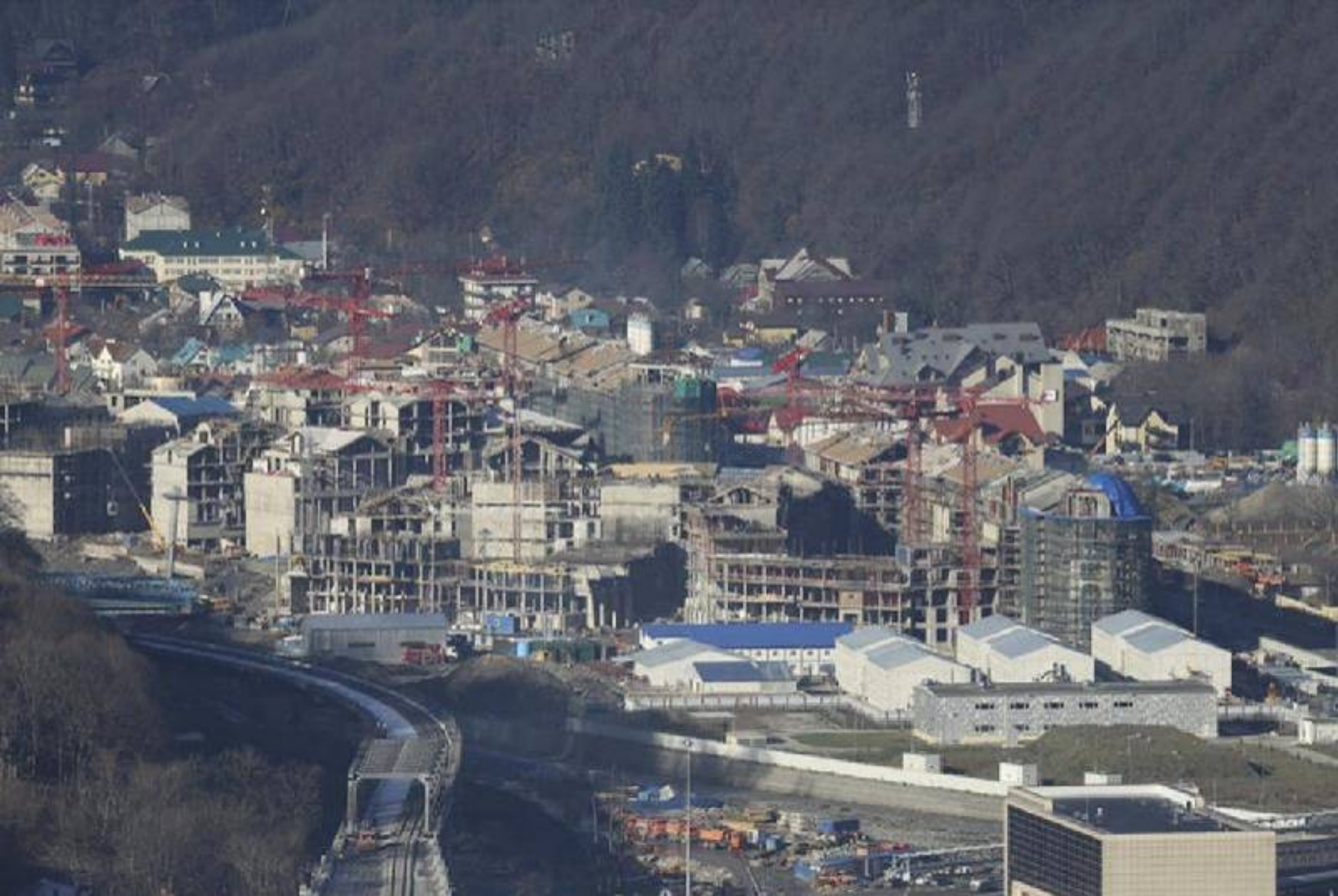
Pogled na delovišče za novo železniško postajo v ,Krásni Poljani' zimski športi na odprtem.
