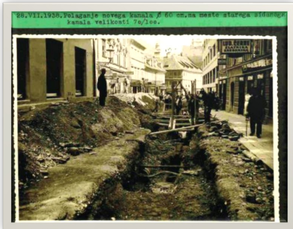
Slika: Polaganje novega kanala
