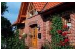
hiša zidana z klinker opeko
