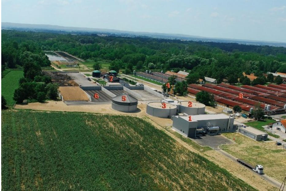
Slika 1: 1. Dostava, predelava in sterilizacija mesnih odpadkov, 2,3 Fermentorji in polnilnica za gnojnico in koruzno silažo, 4. Plinski generatorji, 5. Postfermentacija (filtracija plina), 6. Boksi za silažo, 7. Čistilna naprava, 8. Prašičja farma
