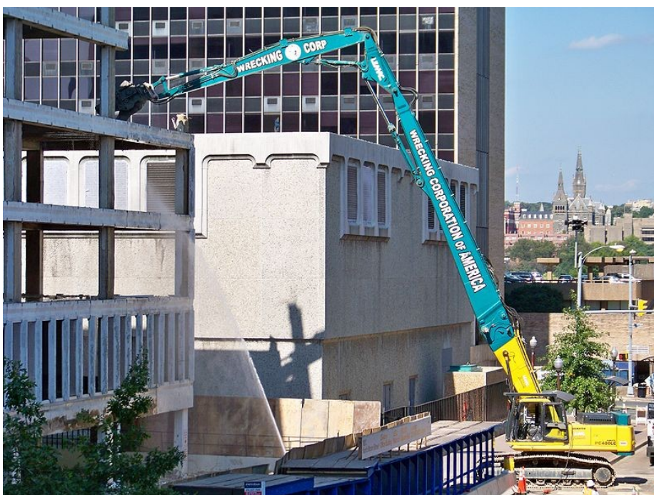
Slika 18:bager z dolgim dosegom roke
