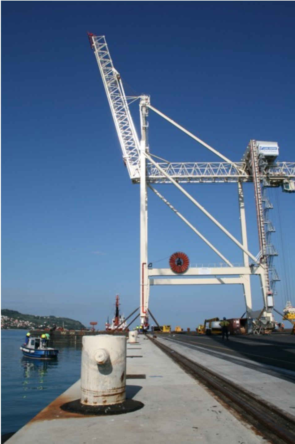
Slika 40: post panamax dvigalo v Luki Koper
