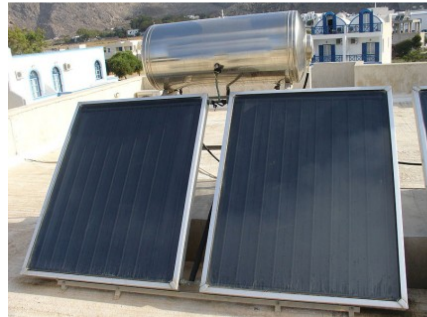
Ploščati kolektor z bojlerjem:
