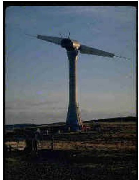
Slika 5 Vetrn elektrarna SLI
