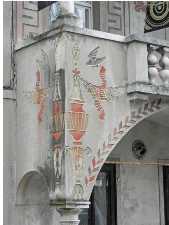
Slika 4 (slika 4 v barvni prilogi): detajl pročelja Križank, Ljubljana, 1952–1956.
