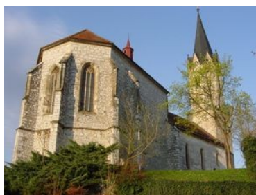
Kapiteljska Cerkev, Novo Mesto
