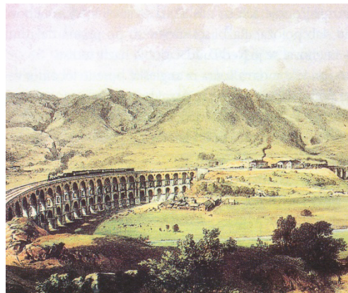
Slika 2: Borovniški viadukt na progi Južne železnice
