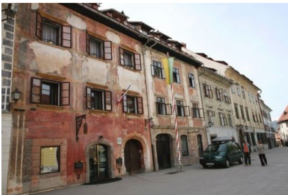
Slika 9: Prenovljena srednjeveška meščanska hiša
